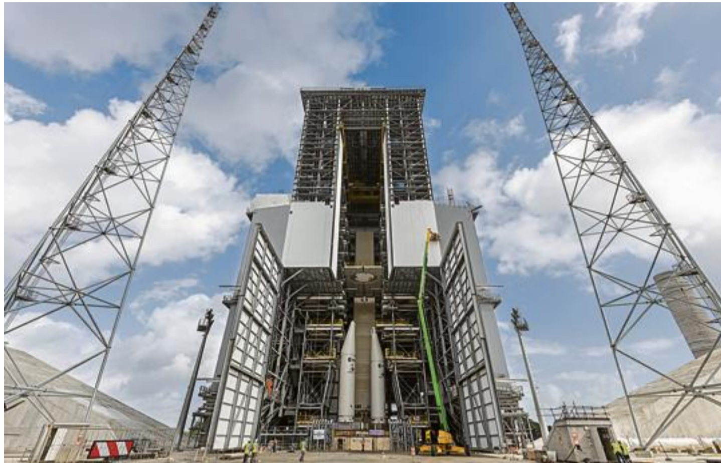
Les essais combinés entre la fusée et le pas de tir ne pourront se faire que lorsque les travaux seront achevés. Photo Jody Amiet/AFP
